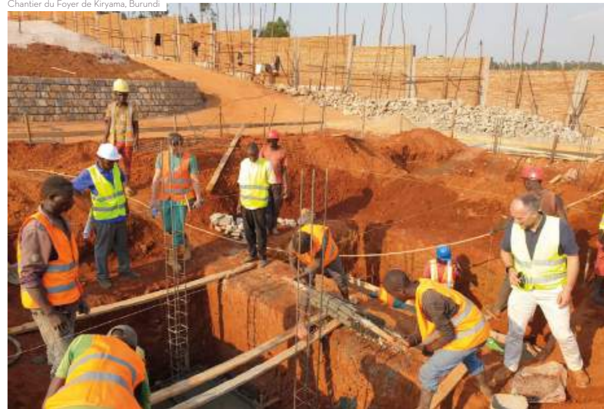
Chantier du Foyer de Kiryama, Burundi
