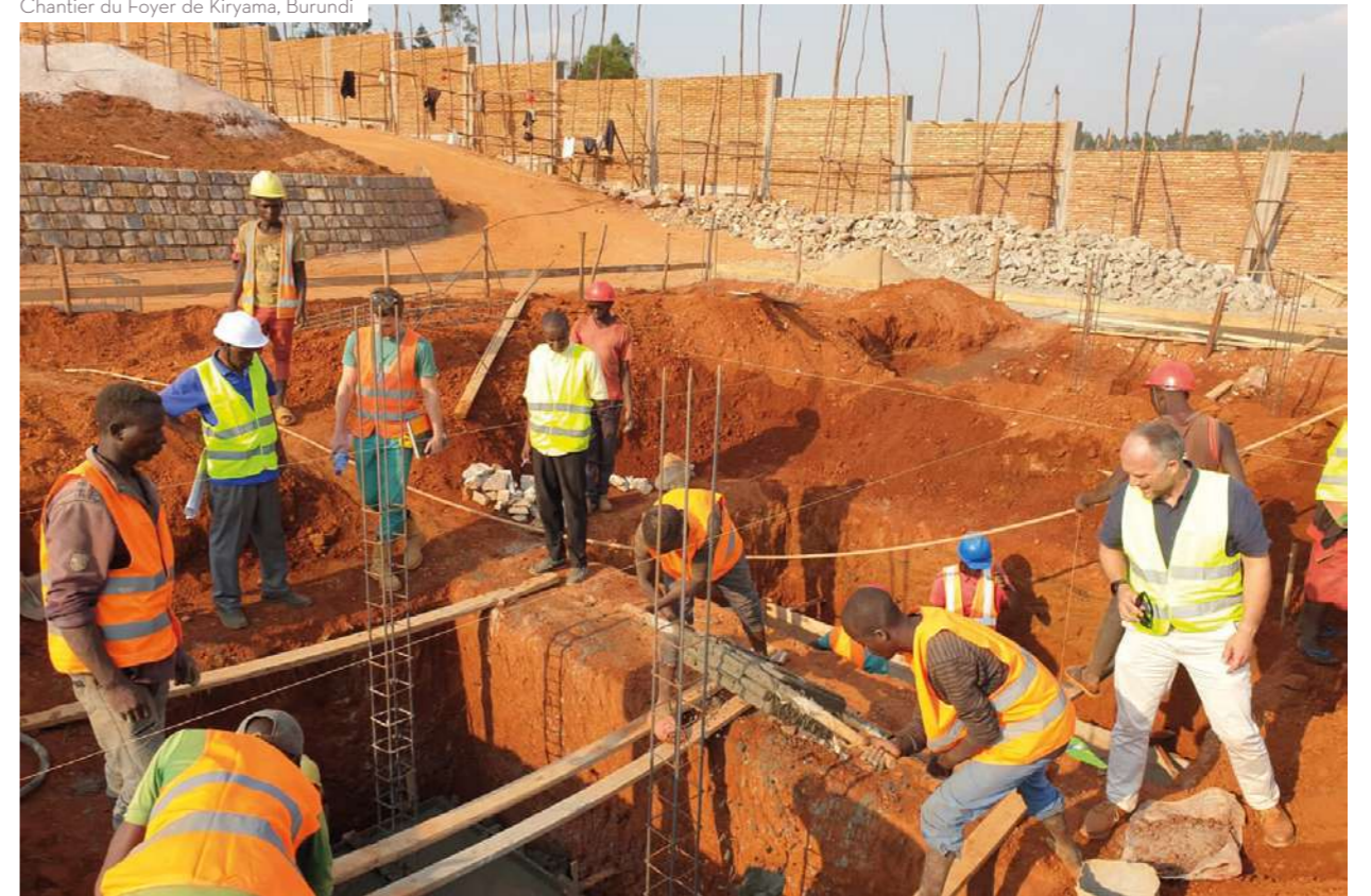
Chantier du Foyer de Kiryama, Burundi
